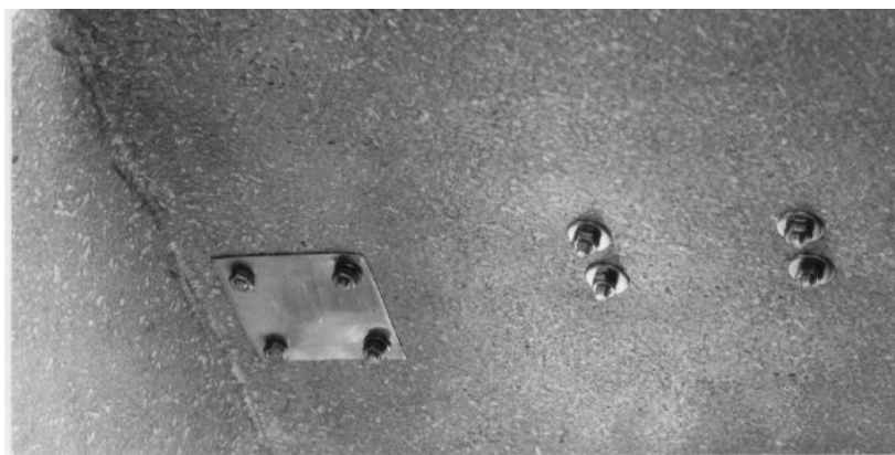
Bild 7. Fästen för vinsch och avlastare sedda inifrån
